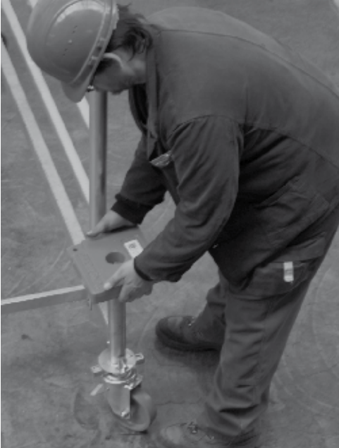
Ballastierung der Traverse
