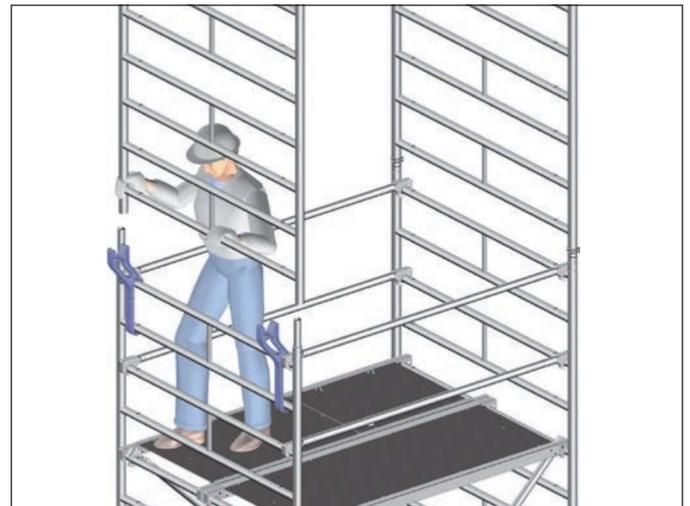
3. Diagonalen und Durchstiegsbrücke einsetzen.
