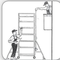
◀ **7** Vor der Verwendung des Gerüsts prüfen Sie, dass die Struktur korrekt und senkrecht aufgebaut ist.
